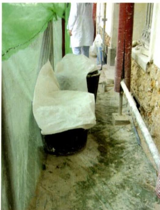
Le mélange à la chaux aérienne, confectionné en atelier, est conservé sur chantier. Le tout étant d'éviter tout contact avec l'air. L'échafaudage est également bâché, afin que l'enduit appliqué soit protégé des intempéries durant sa prise.
