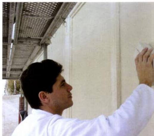
L'enduit de surfacage est frotté avant l'application du lait de chaux.
