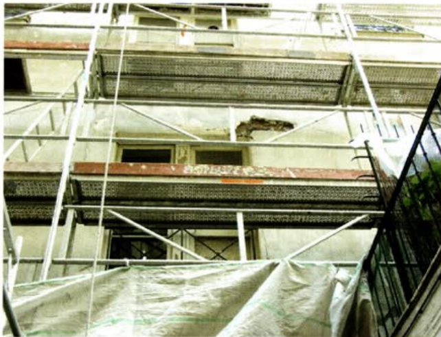
Avant réparation, les pans de bois sont parfois consolidés ou changés. Dans tous les cas, ils ne doivent pas être au contact des mortiers : aussi sont-ils protégés avec des feutres bitumeux, par exemple.
