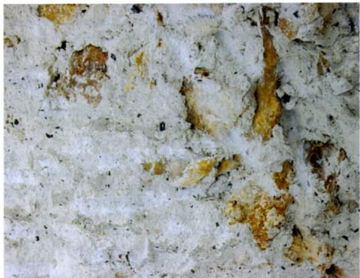
Derrière les revêtements de plâtre, se cachent souvent de drôles de murs. Ces derniers peuvent être composés de meuliers irréguliers dont les interstices sont colmatés avec du charbon, des bouts de bois, de la terre...
