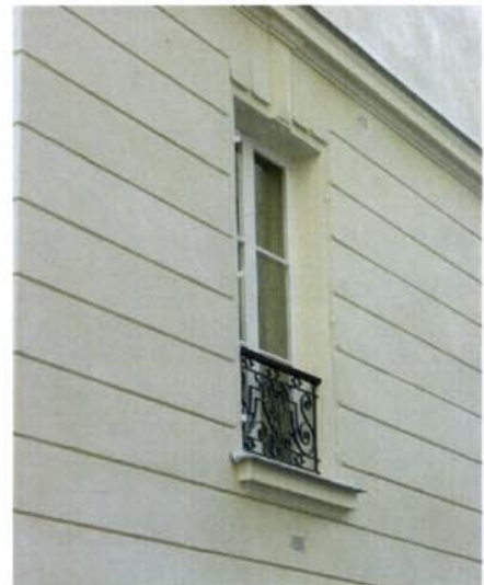
Les façades en plâtre doivent obligatoirement être protégées des ruissellements d'eau. C'est le rôle des éléments architectoniques (bandeaux, corniches...). Précaution supplémentaire, ici, les appuis de fenêtre sont dotés de nez en zinc pour rejeter l'eau sur le devant des modénatures et non sur les côtés.
